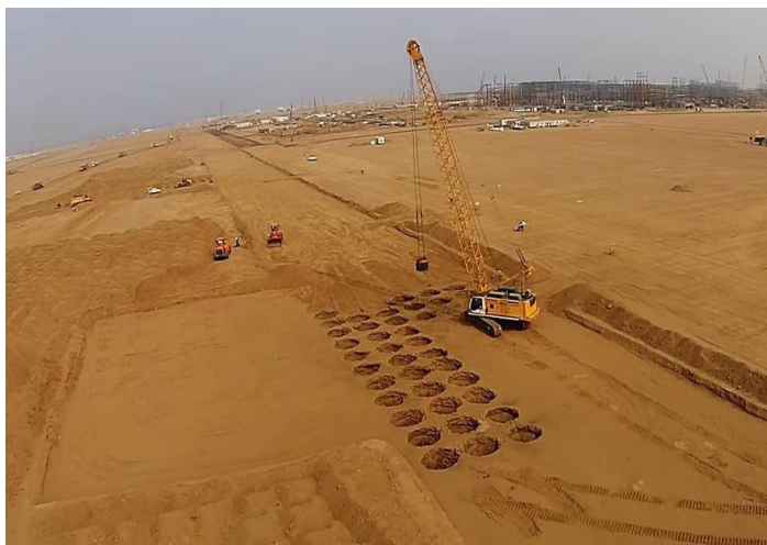
Рисунок 2 – Уплотнение грунта тяжелыми трамбовками (плитой)
