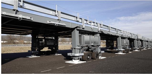
Рисунок 2 – Вид колес передвижного моста
